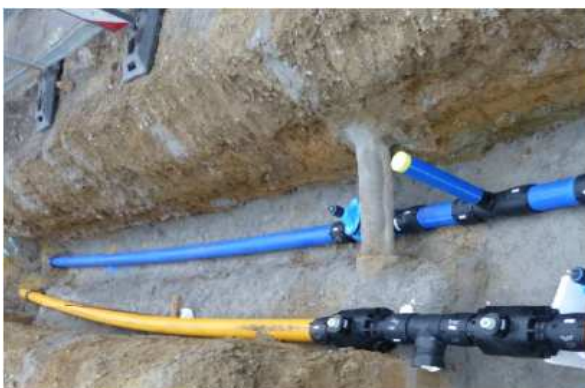
Nach der Verlegung
