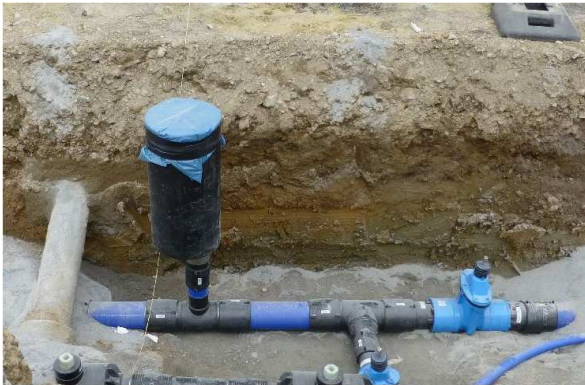
Spezialanfertigung Unterflurhydrant
