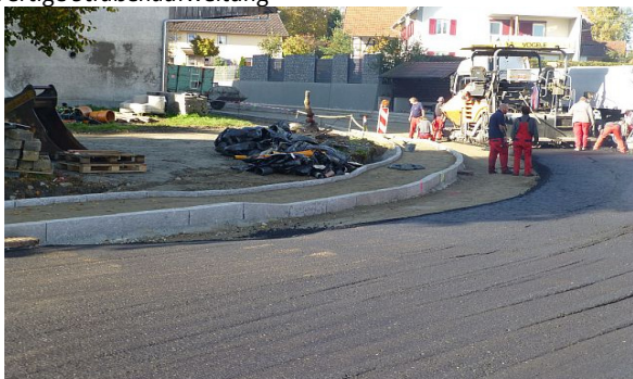
Einbau Asphalttragschicht
