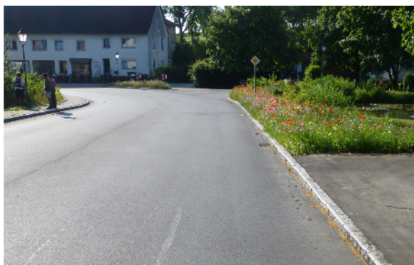
Nach der Straßenaufweitung
