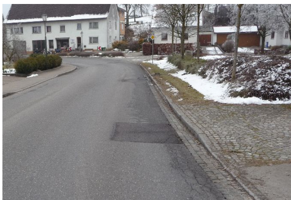
Vor der Straßenaufweitung
