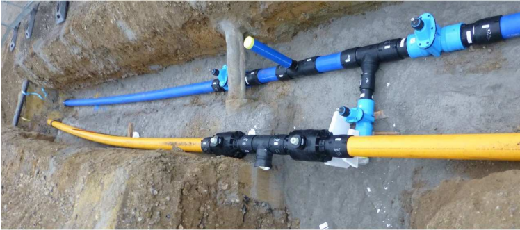
Gasleitung im offenen Graben
