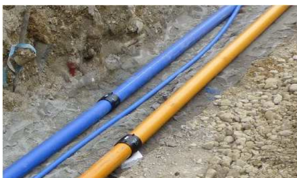
Nach der Verlegung
