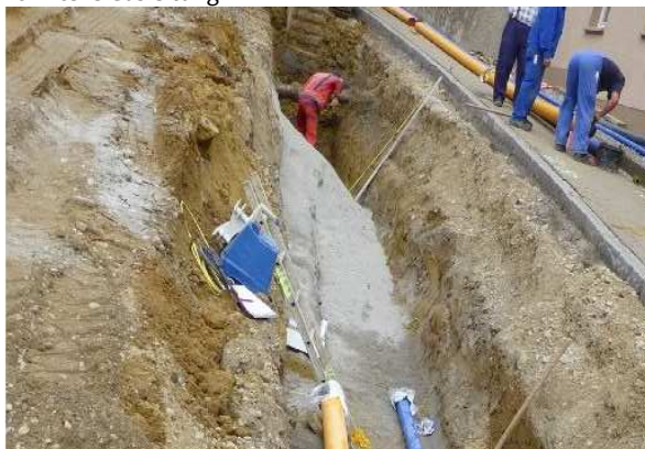
Vorbereitung Gasleitung und Leitungszone
